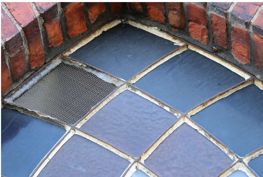
fot. 25: Kaplica cmentarna - widoczna korozja konstrukcji metalowej oraz uszkodzenia kitów.
