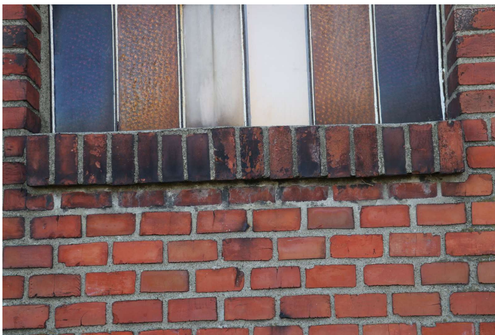
fot. 28: Kaplica cmentarna - widoczne zabrudzenia parapetu.
