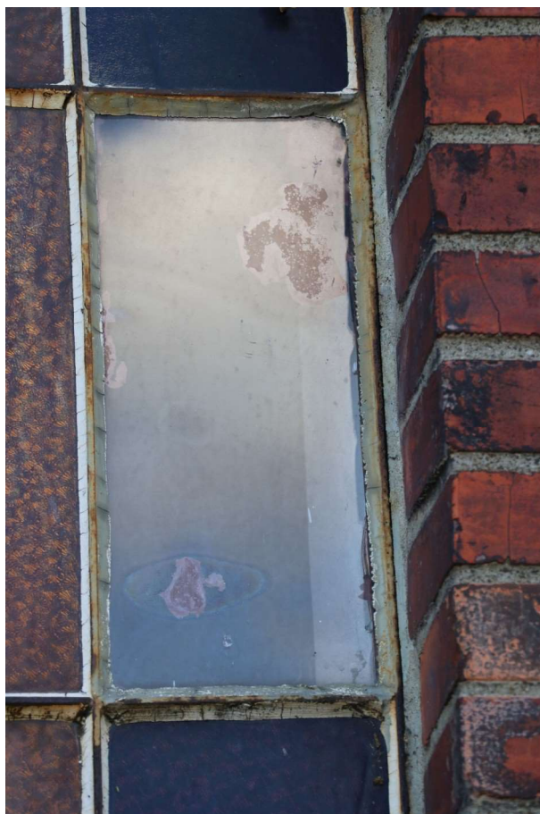
fot. 27: Kaplica cmentarna - widoczna korozja konstrukcji metalowej oraz spękania kitów.
