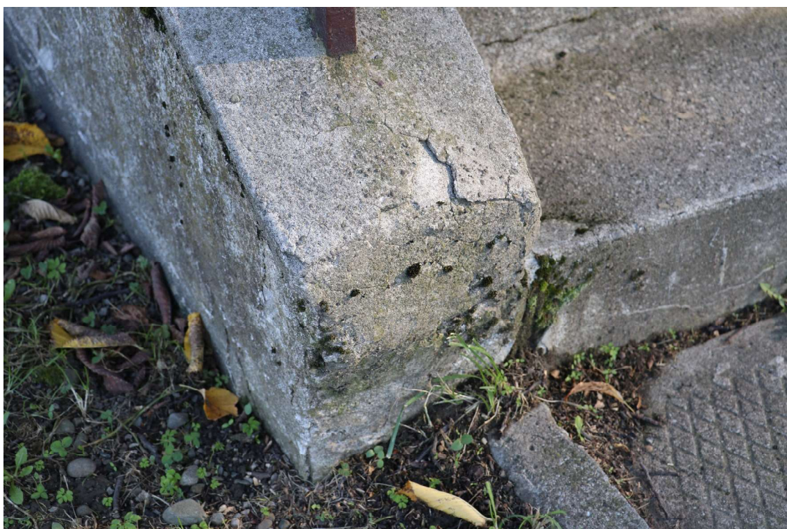
fot. 5: Kaplica cmentarna - widoczne uszkodzenie policzka schodów wejściowych.
