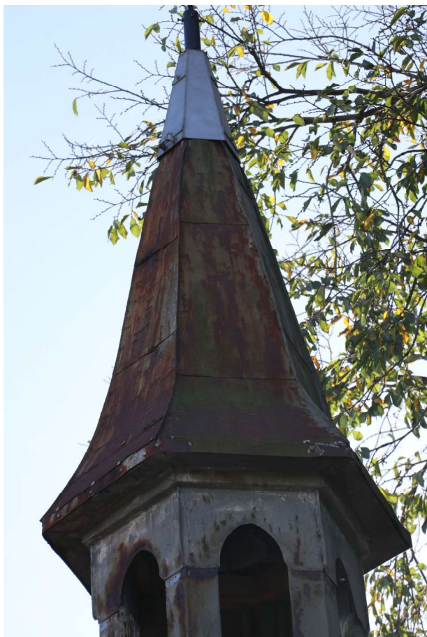
fot. 9: Kaplica cmentarna - skorodowane pokrycie helmu sygnaturki.
