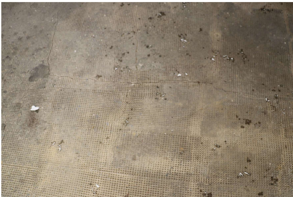
fot. 34: Kaplica cmentarna - widoczne pęknięcia posadzki betonowej.
