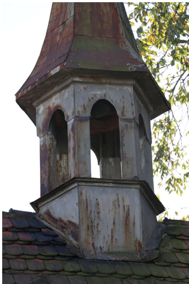
fot. 10: Kaplica cmentarna - skorodowana podstawa sygnaturki.
