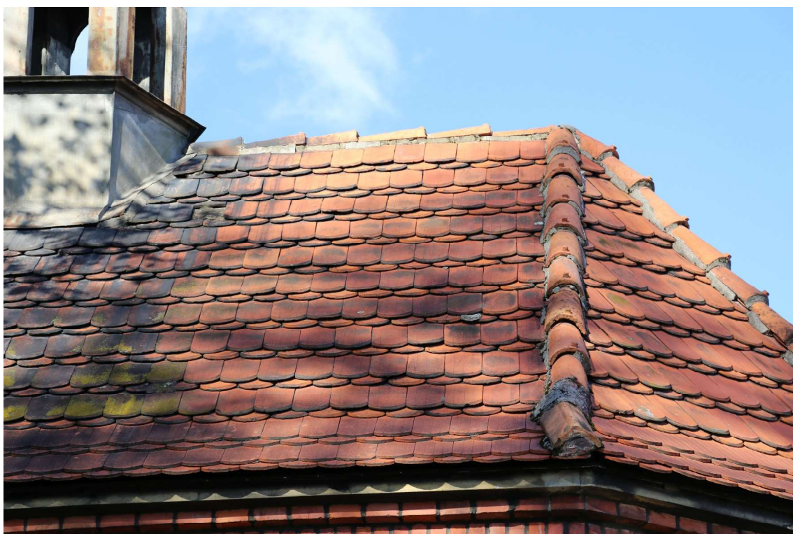
fot. 20: Kaplica cmentarna - widoczny nalot atmosferyczny i biologiczny na pokryciu dachowym.
