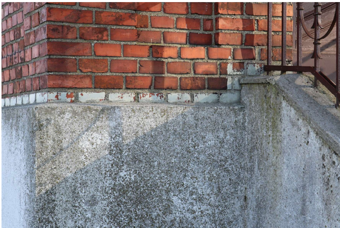
fot. 4: Kaplica cmentarna - widoczna farba olejna pokrywająca rząd cegieł nad podmurówką.
