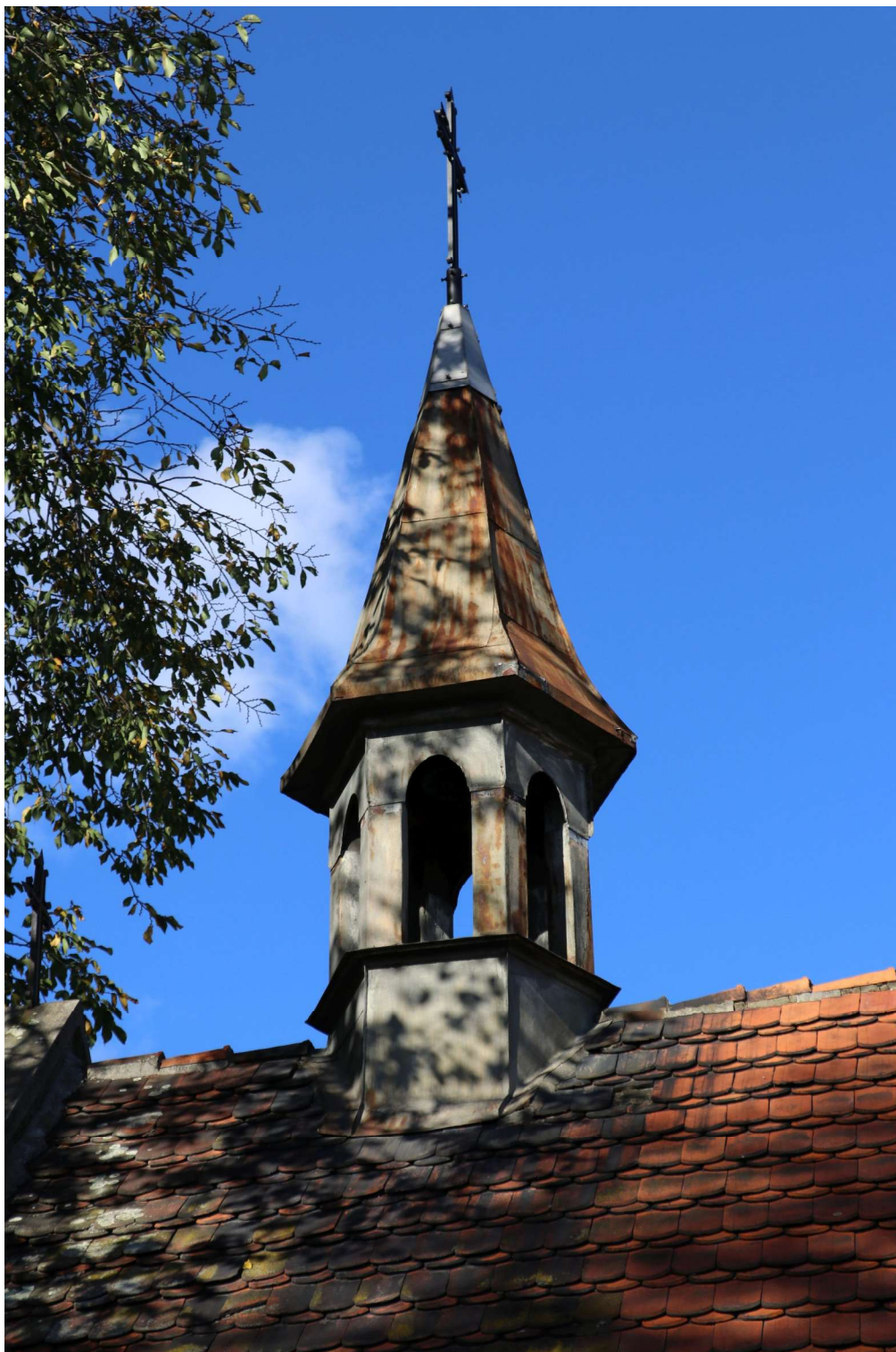
fot. 18: Kaplica cmentarna - widoczna korozja na sygnaturce.
