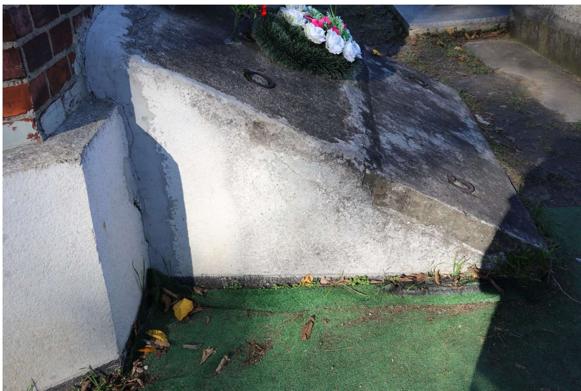
fot. 16: Kaplica cmentarna - wejście do krypty uzupełnione wtórnie zaprawą cementową.
