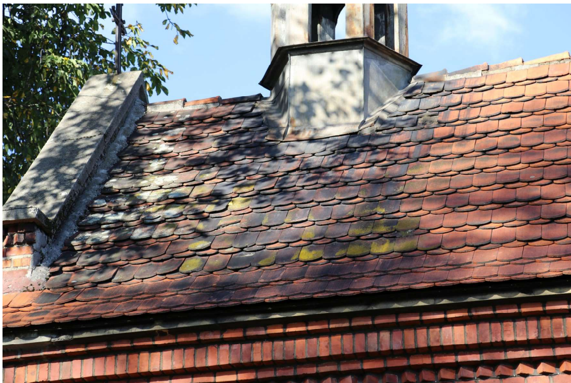
fot. 19: Kaplica cmentarna - widoczny nalot atmosferyczny i biologiczny na pokryciu dachowym.
